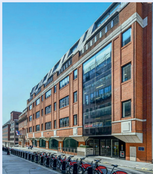
Siège de Tipall Ltd - Bouverie Street - Londres (Royaume-uni)
